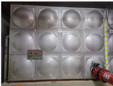
免税大厦 28 楼不锈钢水箱更换项目
