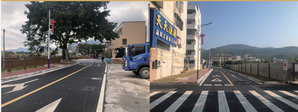
荖园村环村公路建设后
