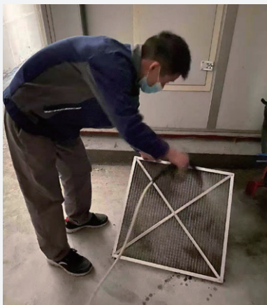
对免税大厦中央空调系统风柜滤网进行清洗
