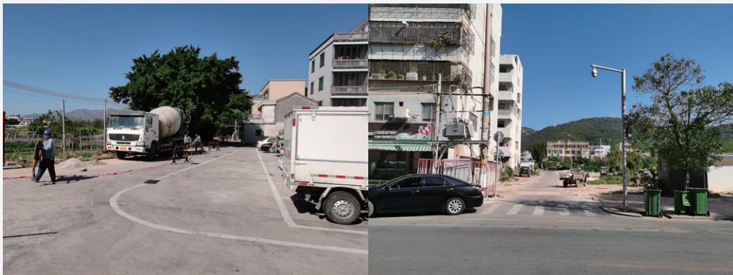
荖园村环村公路建设前
